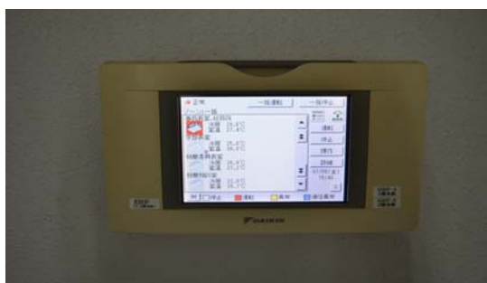
集中監視装置
