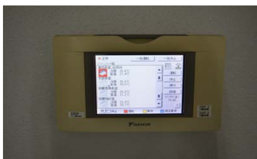
中央監視装置
