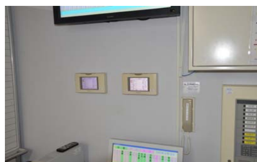
中央監視装置
