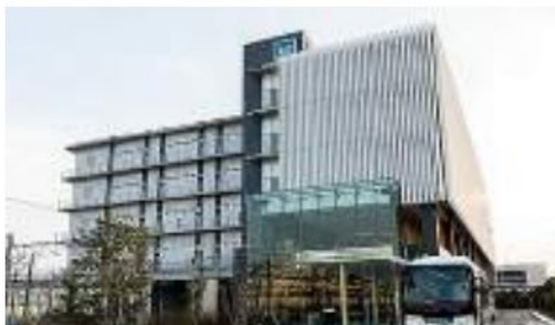
東京地下鉄総合研修センター 東京都江東区
