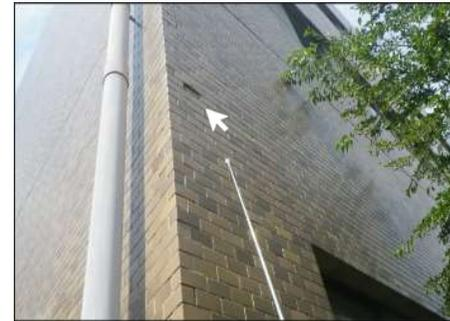
外壁タイル破損、浮き（管理棟）
