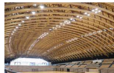
技術支援した大分県立武道スポーツセンター
