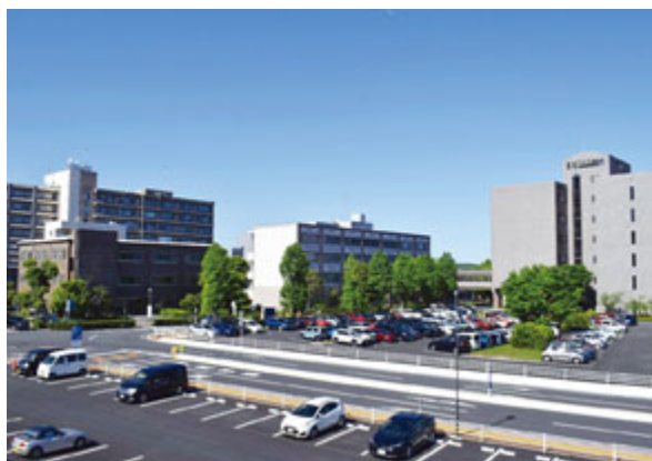
左から基礎・臨床研究棟、医学図書館、校舎講義棟、看護学科棟
