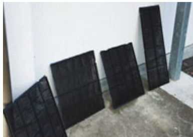
エアコンフィルターの清掃②
