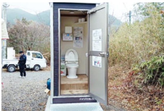
バイオトイレのトイレブース
