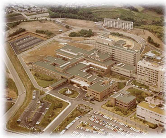
1980（昭和55）年竣工時
